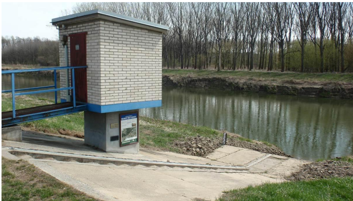
Obr. 9 Hlásný profil kategorie A Strážnice na toku Moravu [Zdroj: vlastní]
