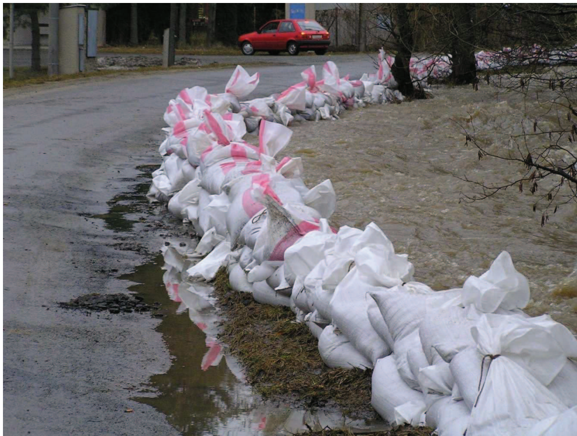
Zabezpečení koryta potoka u skladu civilní obrany [17]
