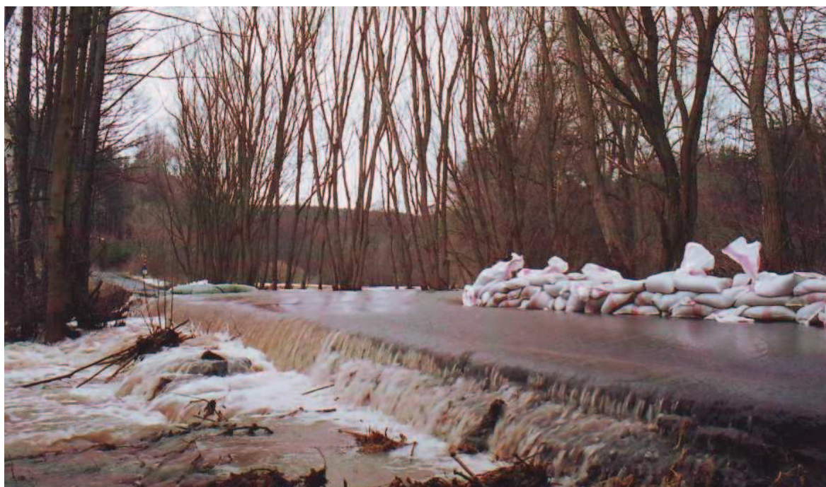
Hráz z pytlů mezi rybníkem a silnicí [17]
