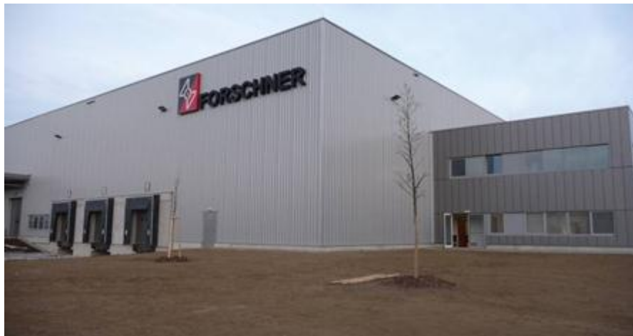
Obr. 11 Budova výroby v Uherském Hradišti (Forschner, 2008)
