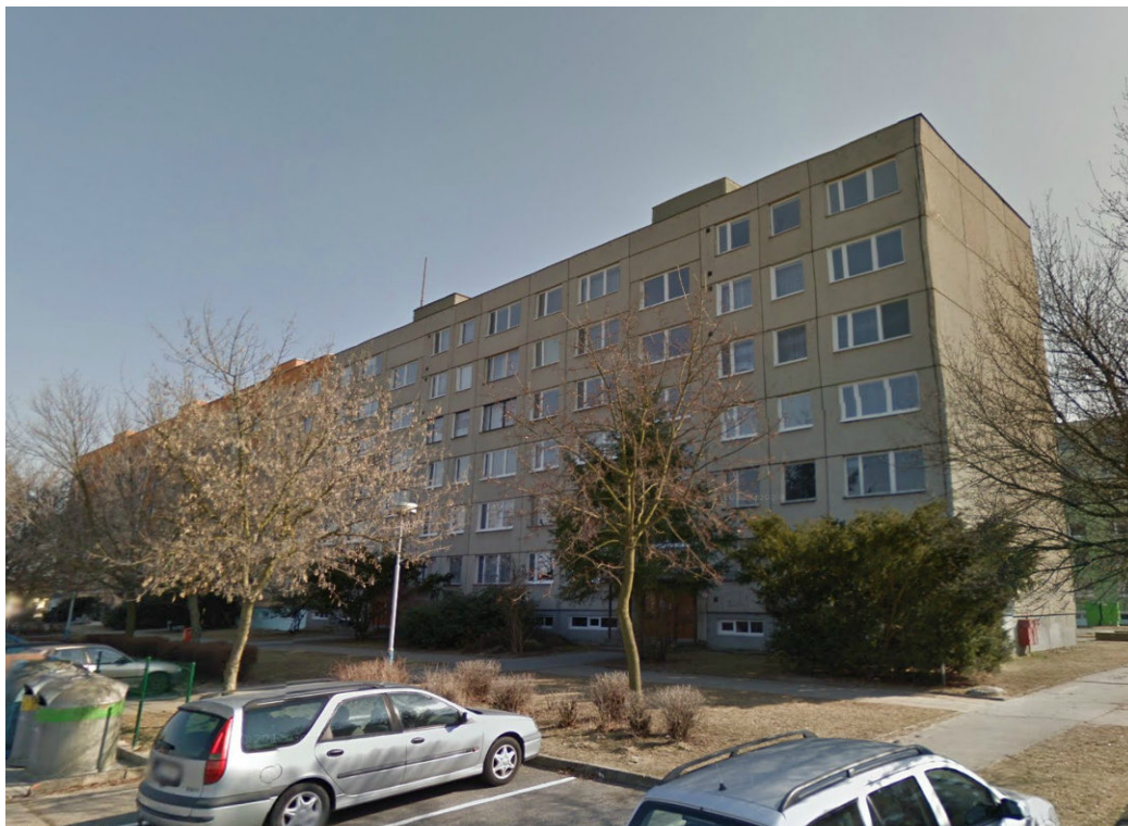
Obrázek 16 – Panelový dům nacházející se na sídlišti Na Valtické
