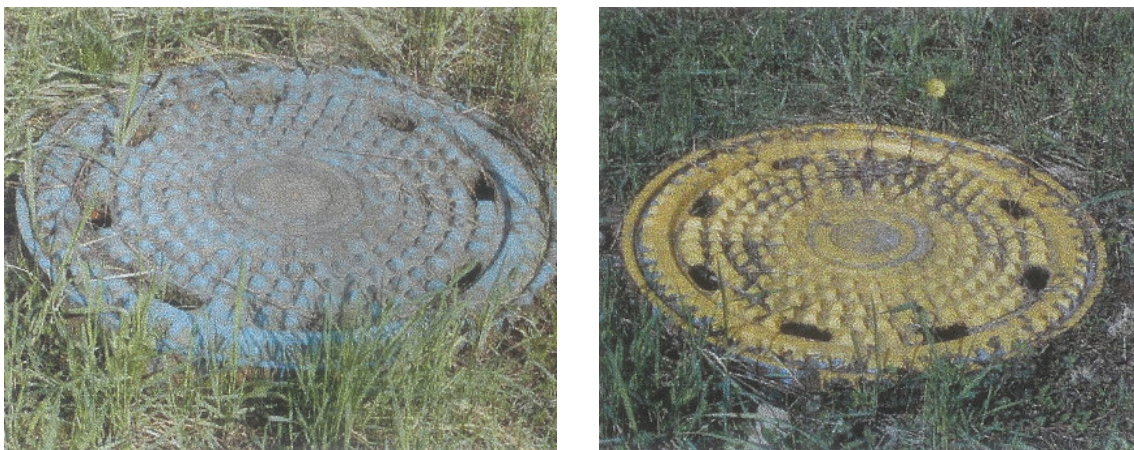
Obr.č11.:Barevné rozlišení kanalizačních sítí
