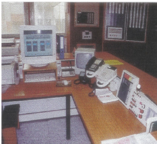
Obr.č1.: Ohlašovna požáru
