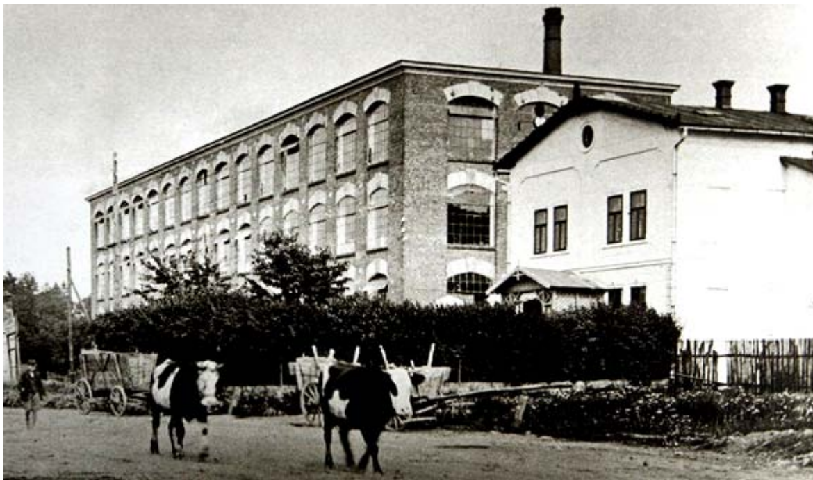
Obr. 10 První tovární budova firmy Baťa a.s. postavená v roce 1906 (Pokluda, 2007, s. 62)
