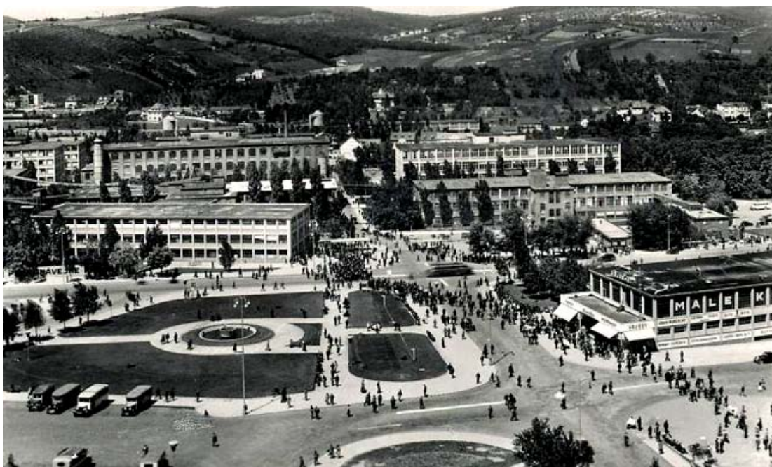
Obr. 15 Historická fotografie Náměstí Práce – pohled na vstup do továrního areálu (soukromý archiv autorky)
