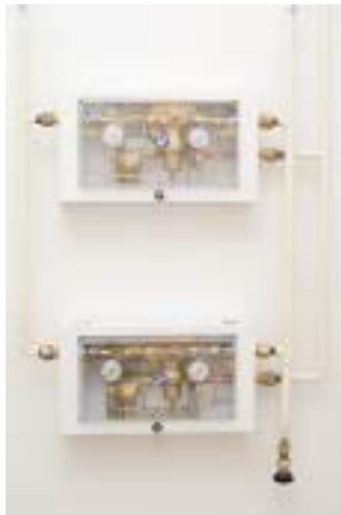
Obr. 8. Rozvody medicijnálních plynů
