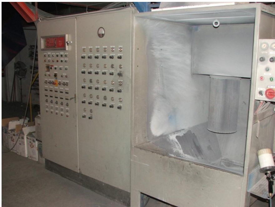
Obrázek 12 Komorový stříkací box s rozvaděčem (Interní zdroje firmy)
