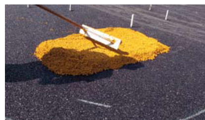
Obr. 21. Rozprostření nášlapné vrstvy EPDM granulátu
