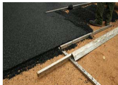
Obr. 20. Pokládka spodní vrstvy
