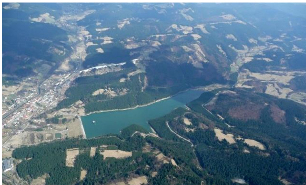
Obr. 4 Přehrada Stanovnice pohled shora [8]
