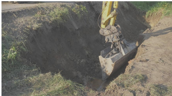
Obr. 19 Vybagrování kontaminované půdy [Zdroj: Hasiči UH]
