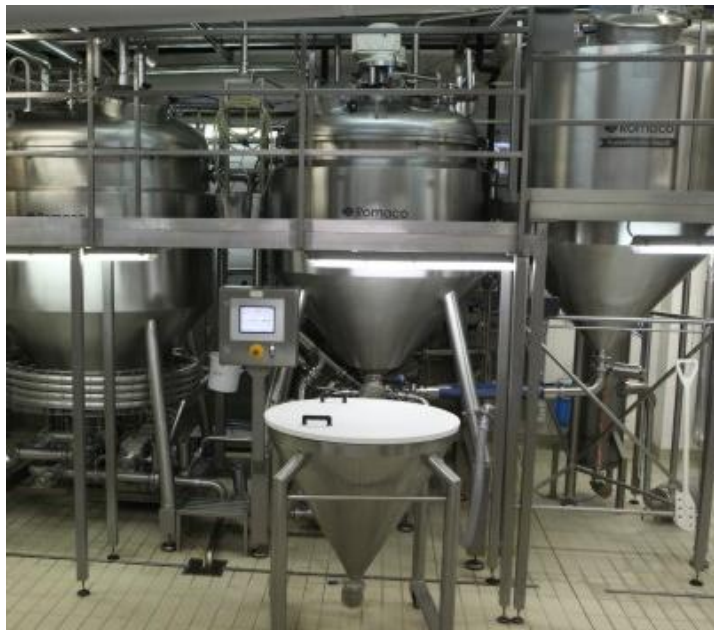
Obrázek 9: Varné zařízení, v popředí dávkovací nerezový zvon [57]
