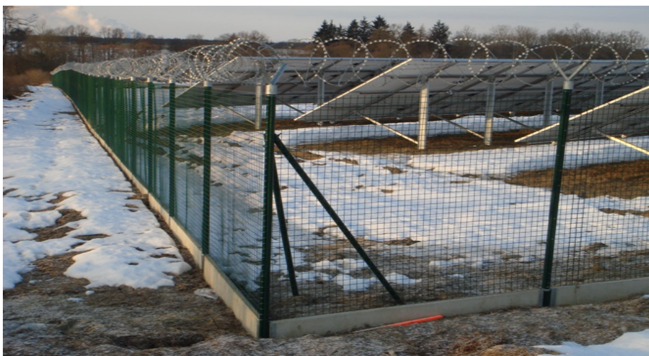
Obr. 2 Plotový systém s vrcholovou a podhrabovou zábranou [Zdroj: 6]
