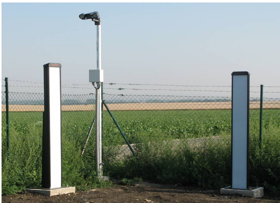
Obr. 12 CCTV + IR modul, duální elektronické bariéry [Zdroj: vlastní]
