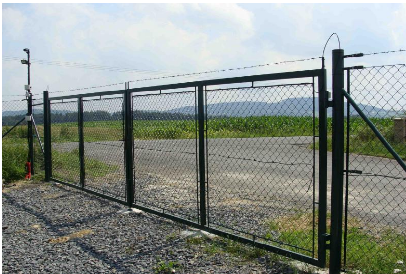
Obr. 4 Perimetrický sensorický kabel na pletivu brány [Zdroj: 4]
