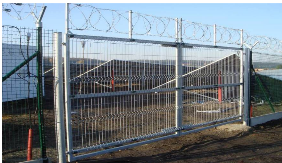
Obr. 3 Vstupní brána do objektu FVE s žiletkovým drátem [Zdroj: 6]
