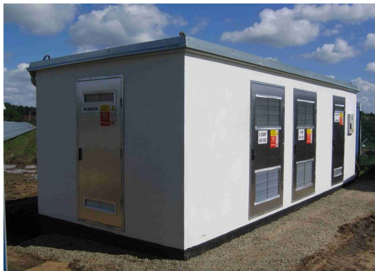
Obr. 10 Trafostanice s betonovým skeletem [Zdroj: vlastní]
