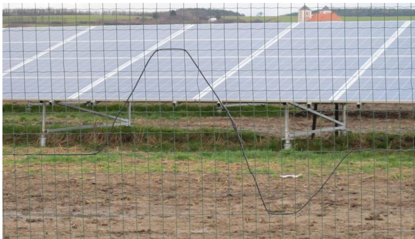
Obr. 11 Zakřivení perimetrického kabelu typu "Z" [Zdroj: vlastní]
