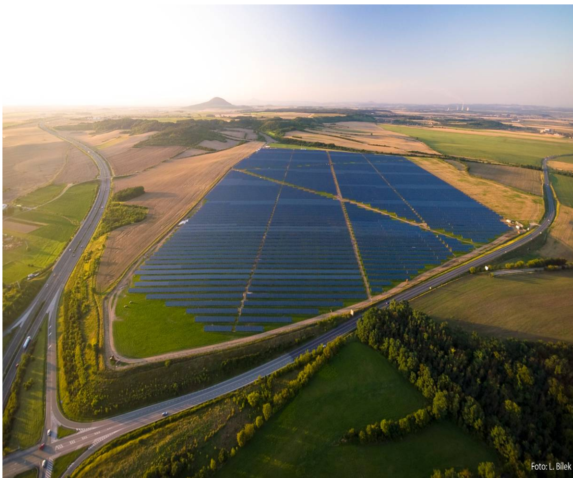
Obr. 8 Fotovoltaická elektrárna Vepřek, okres Mělník, výkon 35,1 MW [Zdroj: 15]
