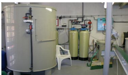
Obr. 16 Výroba deionizované vody [24]
