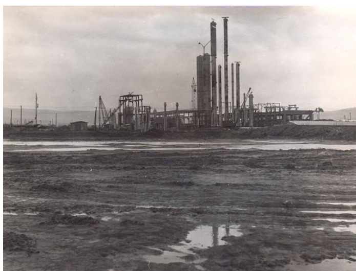
Obr. 9 Výstavba firmy ve Valašském Meziříčí [21]
