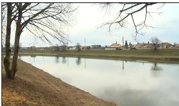
Obr. 13 Stavba protipovodňové hráze v Uherském Hradišti
