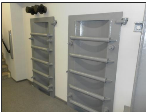
Obr. 6 Tlaku odolné ocelové dveře v kině Hvězda
