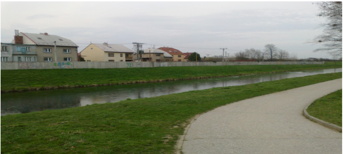
Obrázek 9 Ohrazení toku pomocí betonové zdi [Zdroj: vlastní]
