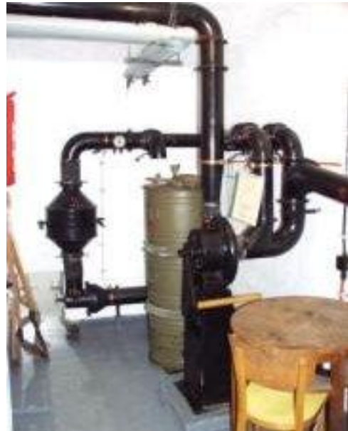
Obr. 4 a Obr. 5 – Vstup do stálého úkrytu a filtroventilační zařízení [Zdroj: 21]
