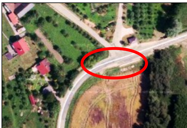
Obr 4. Úsek poškozené místní komunikace
