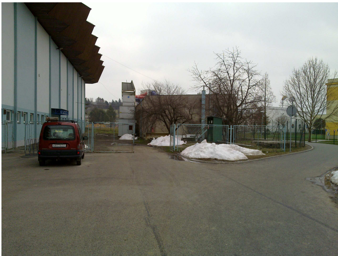
Obr. 4. Strojovna s chladicím zařízením
