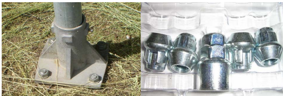
Obr. 21. Patka se sloupem (vlevo) [Zdroj vlastní], bezpečnostní matice (vpravo) [78]
