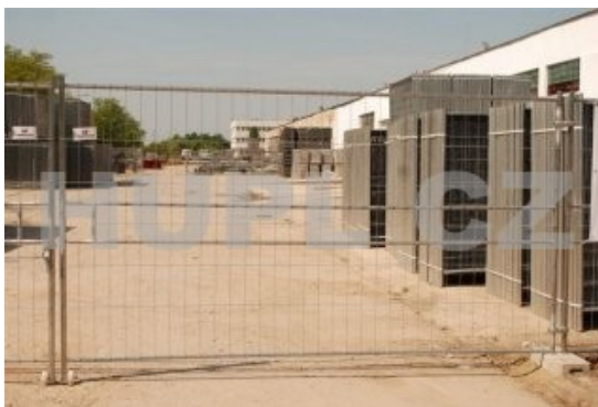
Obr. 37. Brána mobilního oplocení s kolečky [93]
