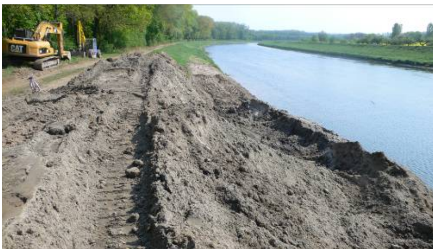
Obr. 2. Těžká technika Povodí Moravy pro eliminaci sedimentů [Zdroj vlastní]
