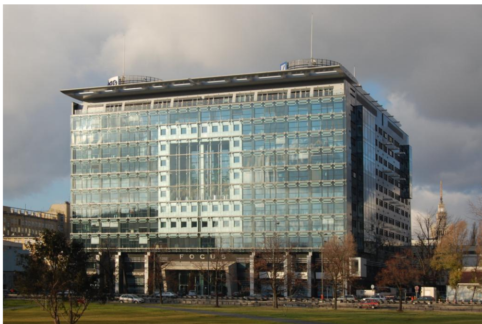
Obr. 28 Sklo jako obkladový materiál budovy FOCUS ve Varšavě (Polsko)
