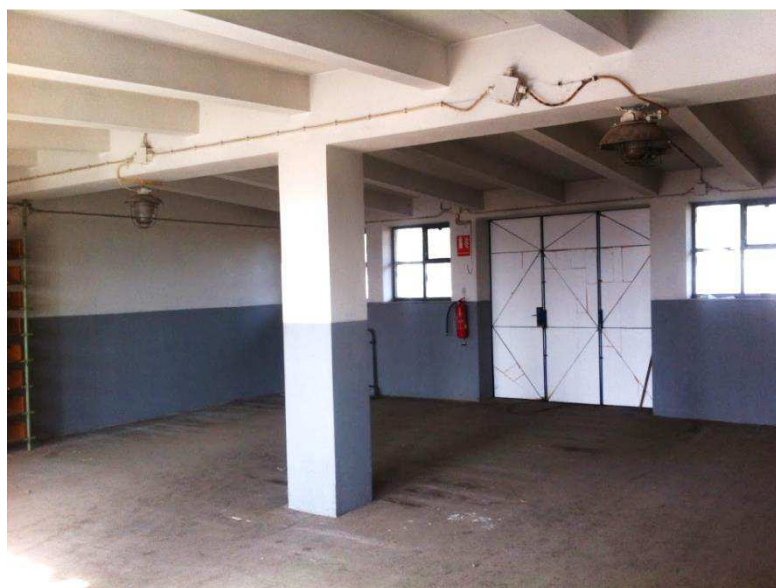
Obr. 27. Předpokládaný SKLAD 2 – práškové barvy
