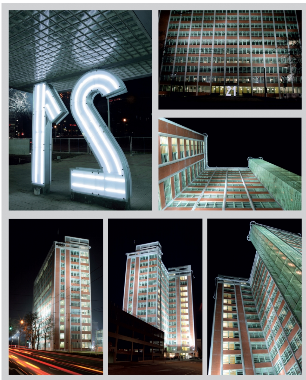
Obrázek 11 Budova č. 21 po rekonstrukci, zdroj: S-Projekt
