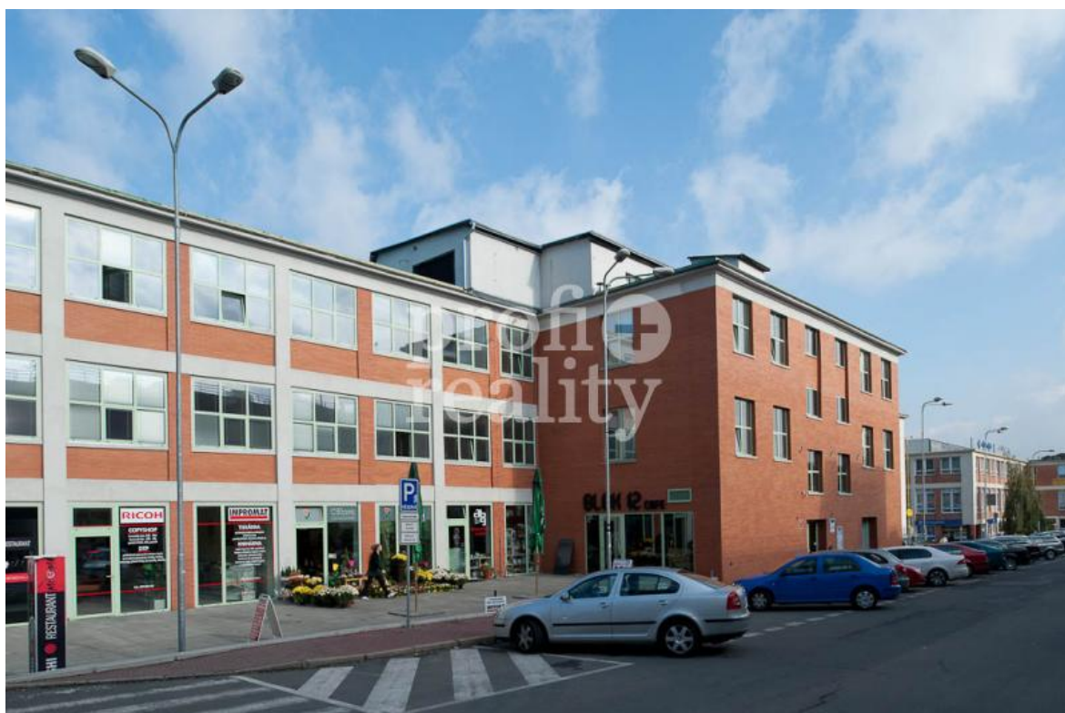
Obrázek 13 Budova č. 12 po rekonstrukci, zdroj: Profireality
