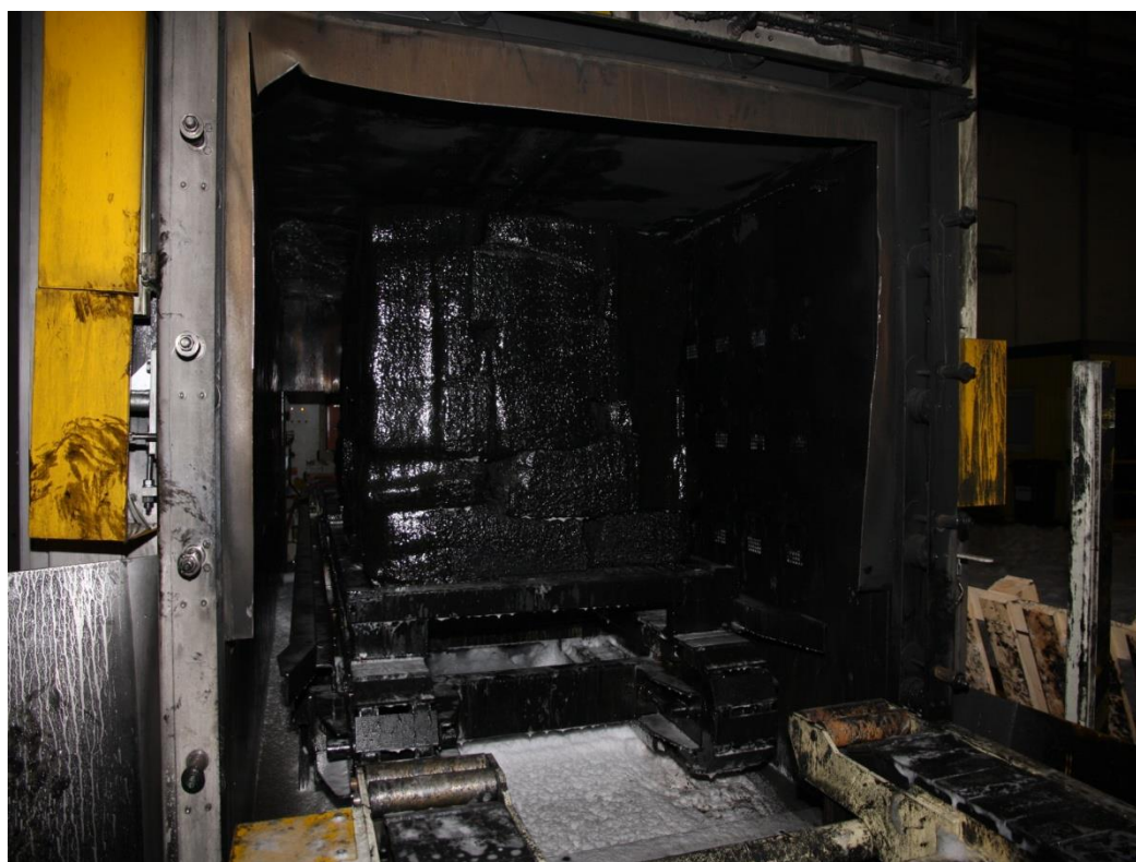
Obr. 15 Mikrovlnná komora Continental Barum s.r.o. - následky požáru.
