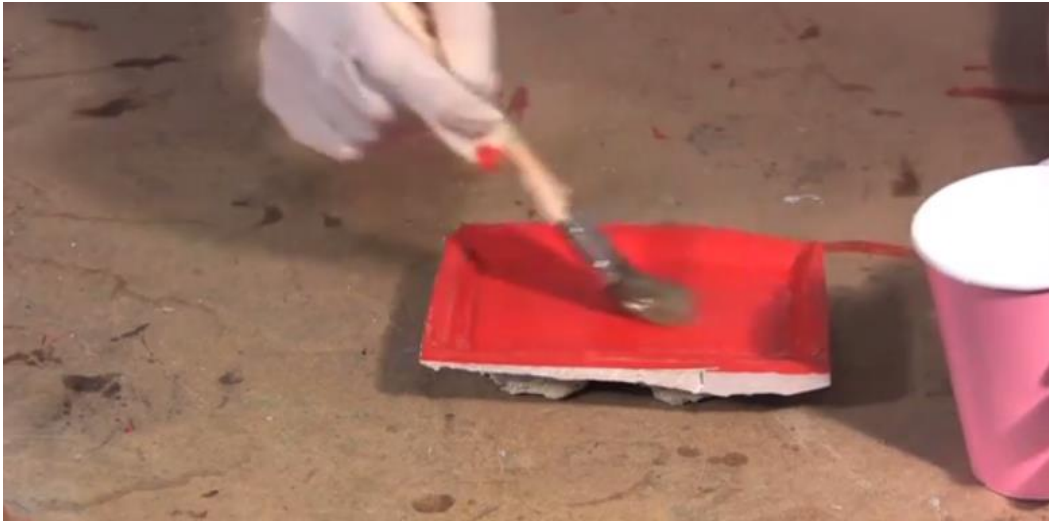
Obrázek 9- nanášení směsi epoxidové pryskyřice s iniciátorem
