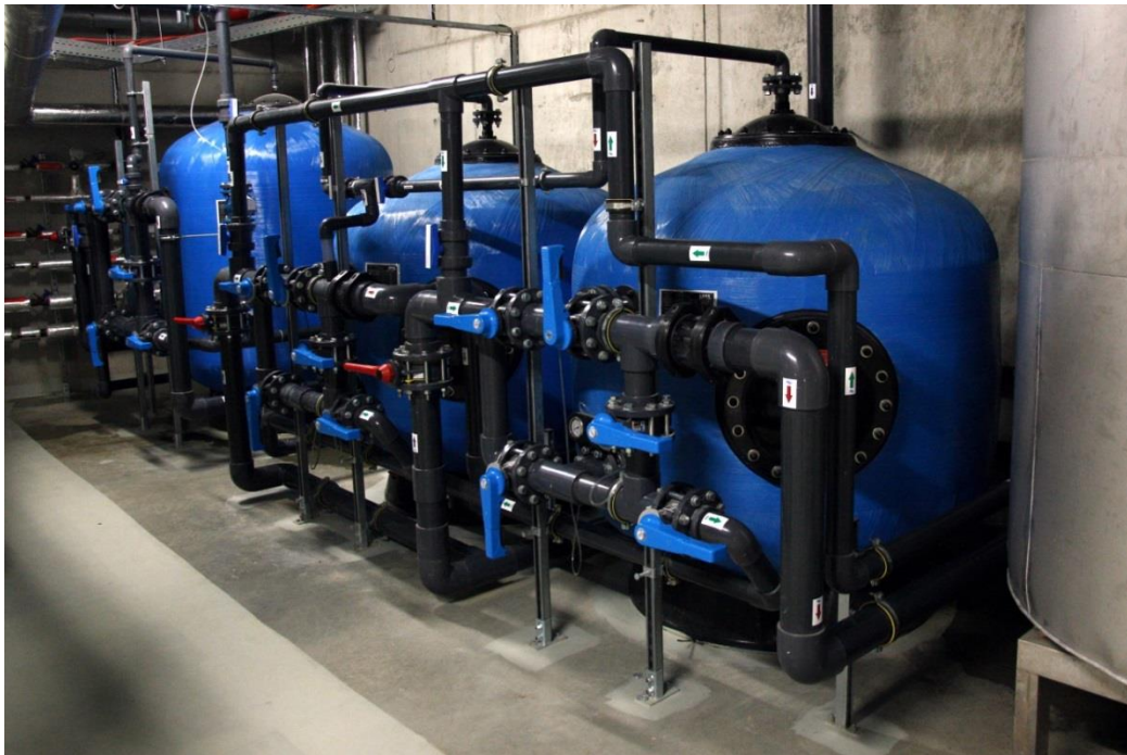
Obr. 3. Uspořádání více pískových filtrů paralelně
