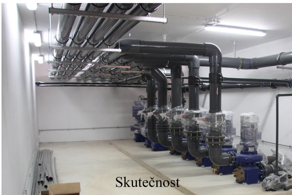
Obr. 20. Renderovaný snímek vs skutečnost objekt strojovny filtračního okruhu C
