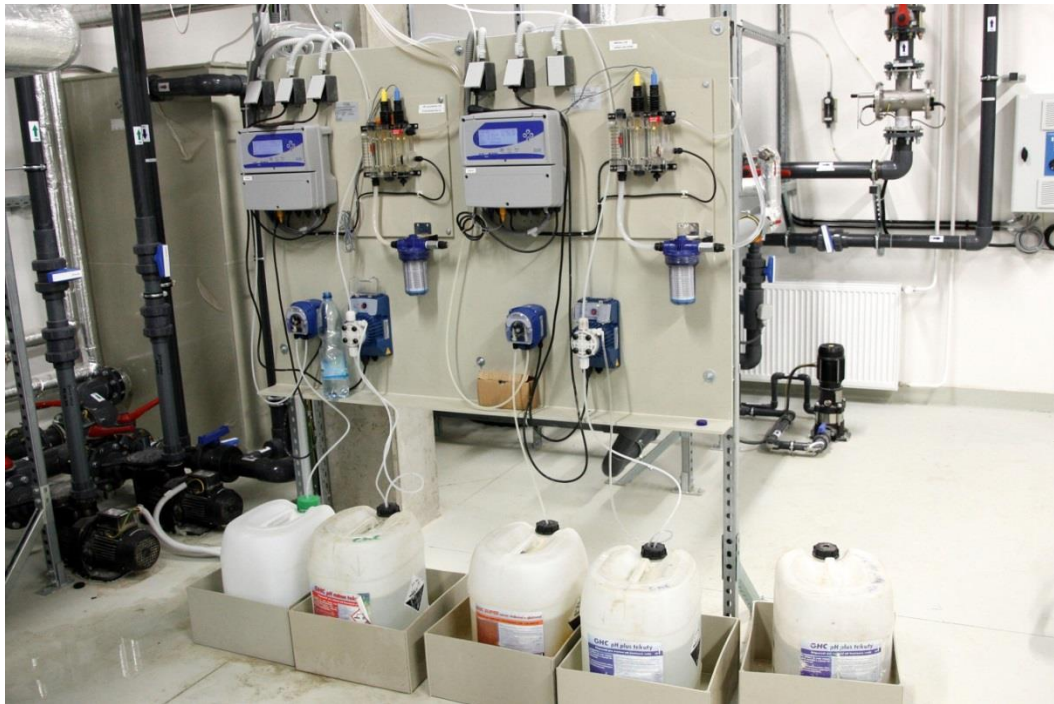
Obr. 6. Úprava - měření pH, Cl, Redox
