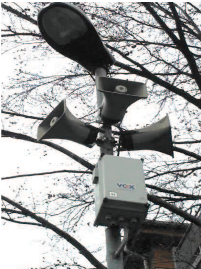
Obr. 20 Hnízdo bezdrátového hlásiče na Studentském náměstí v Uherském Hradišti
