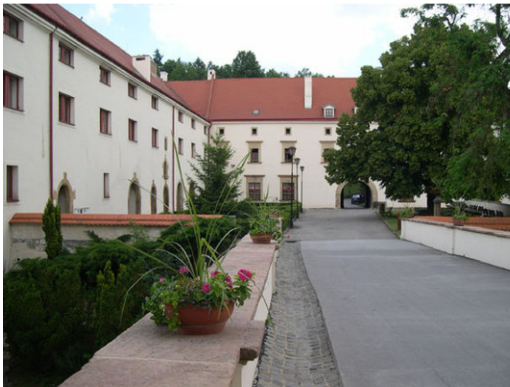
(Fotografie č.1, Budova Domova pro seniory Černá Hora )
