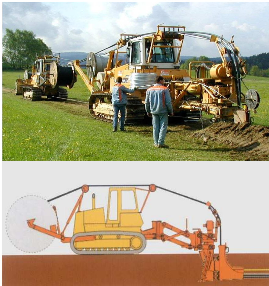
Obr. 11. Strojová pokládka kabelového vedení [18]
