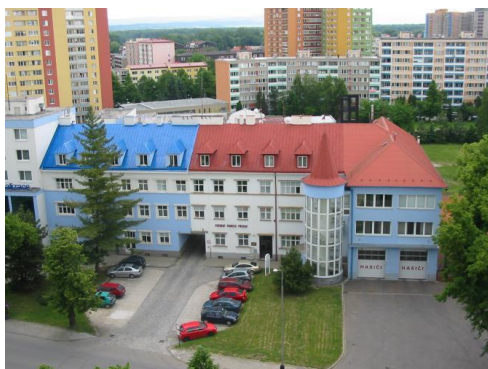
Obrázek 2 Požární stanice Přerov
