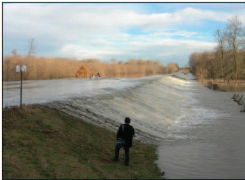
Obrázek 15: Přeliv vody přes PB inundační hráz Skařiny [22]
