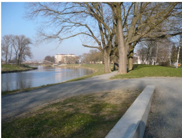
Obrázek 8 Hliněná hráz sídliště Štěpnice [vlastní]
