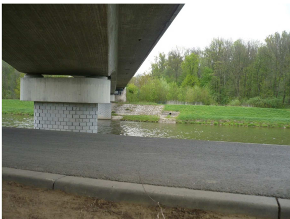
Obrázek 18 Silniční most obchvatu [vlastní]
