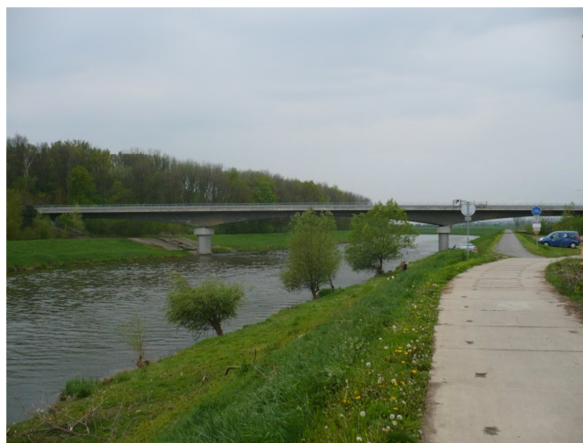
Obrázek 19 Silniční most obchvatu [vlastní]
