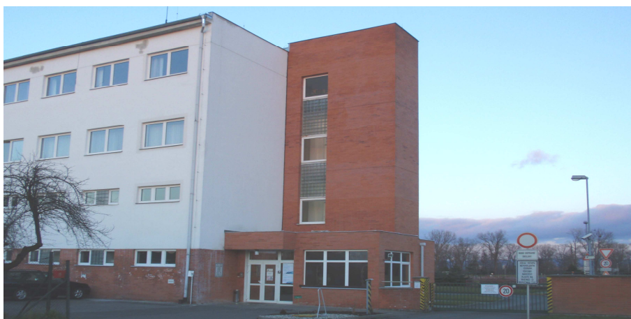
Obr. 5. Administrativní budova ČOV Olomouc. Zdroj: [vlastní]
