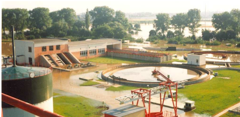
Obr. 15. Zaplavení areálu ČOV – přítoková část. [14]
