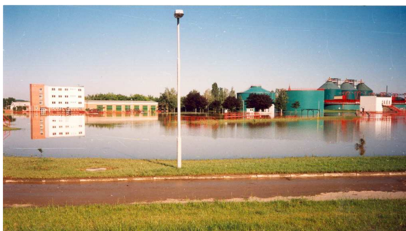
Obr. 17. Zaplavení areálu ČOV - hlavní budova a garáže. [14]
