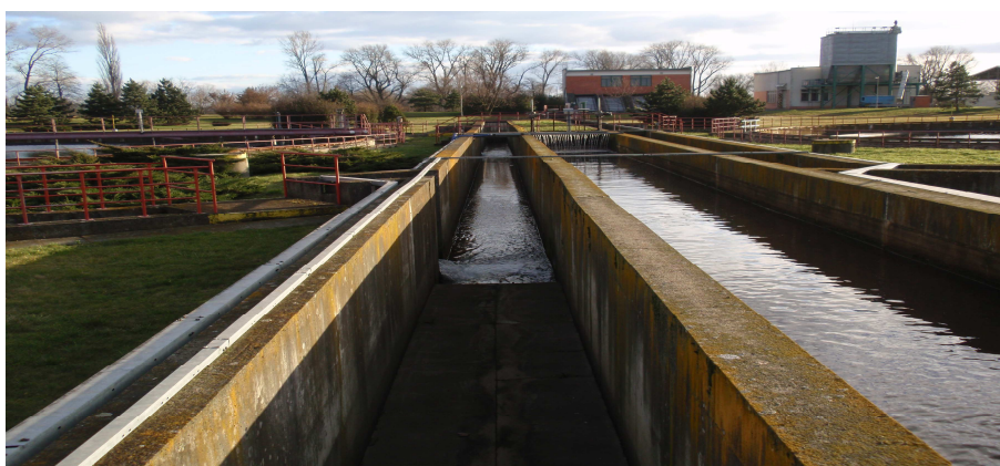
Obr. 10. Odlehčovací stoka. Zdroj: [vlastní]
