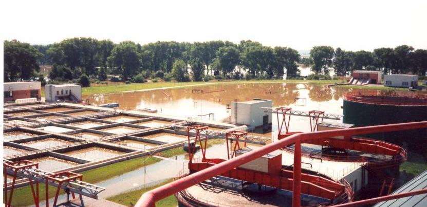
Obr. 16. Zaplavení areálu ČOV – dosazovací nádrže. [14]
