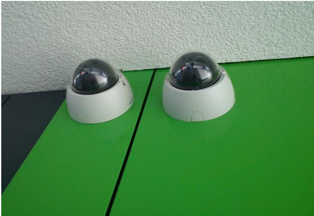
Obr. 28: Namontované kamery AVIGILON
