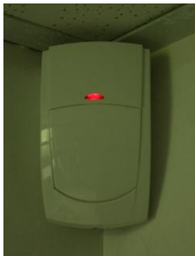
Obr. 17: Namontovaný PIR snímač Prestige IR
