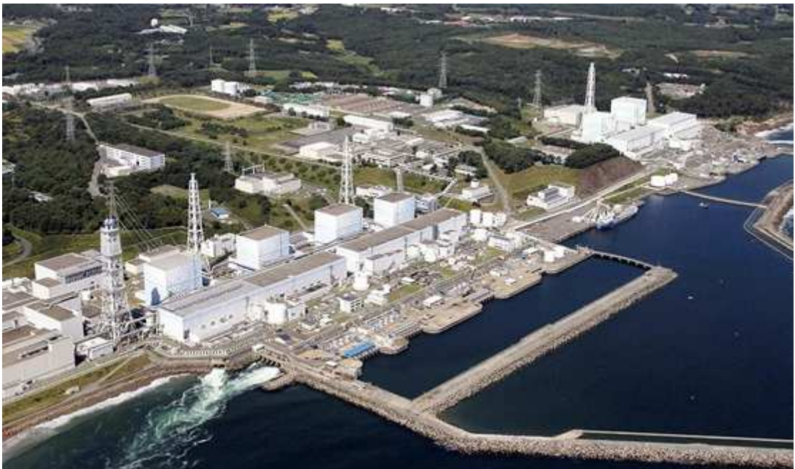
Obrázek 15 Letecký pohled na jadernou elektrárnu Fukušima [28]
