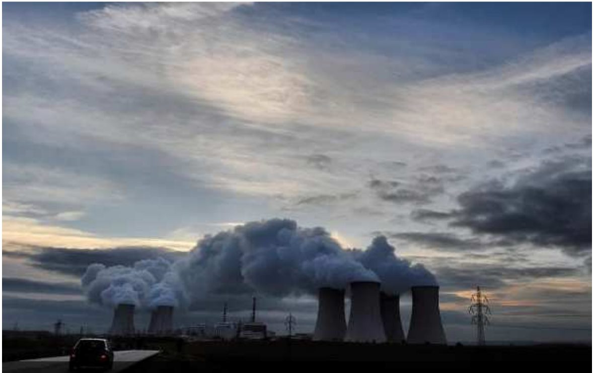
Obrázek 20 Jaderná elektrárna Dukovany [36]
