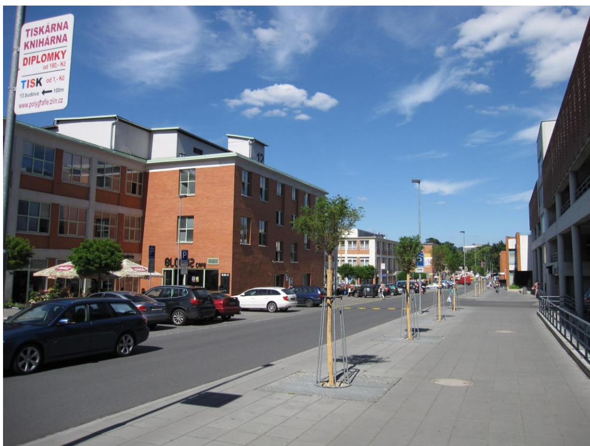
Obrázek č. 10 – Pohled na ulici J. A. Bati
