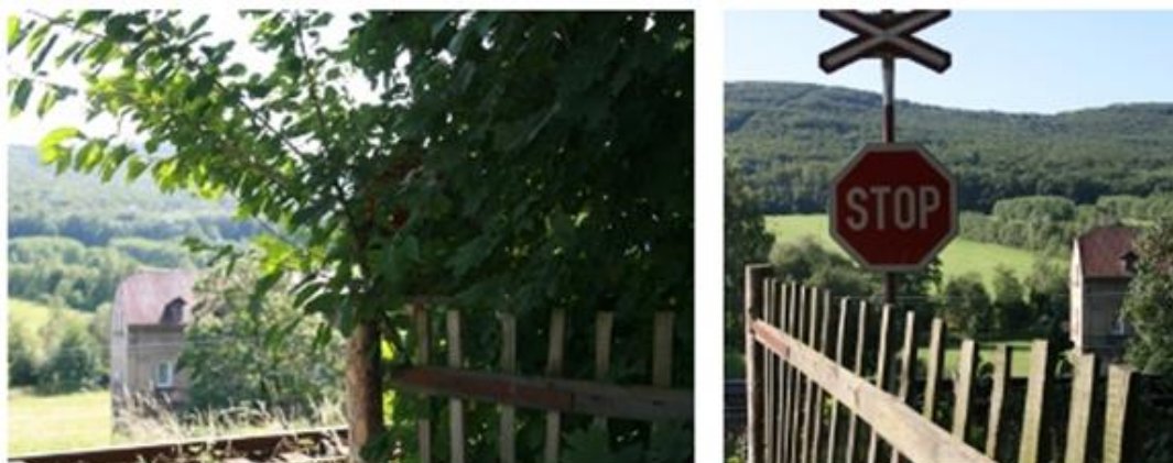
Obr. 11 Zakrytý výstražný kříž odhalený Drážní inspekcí a následná náprava [18]
