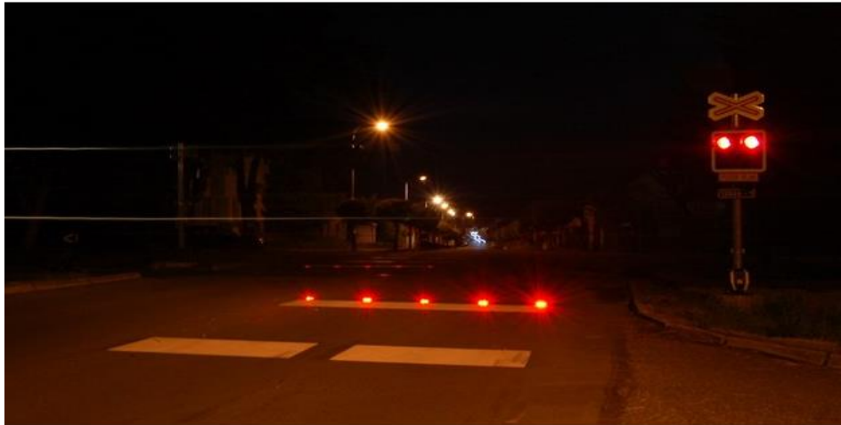
Obr. 12 Světelné označení železničního přejezdu [27]
