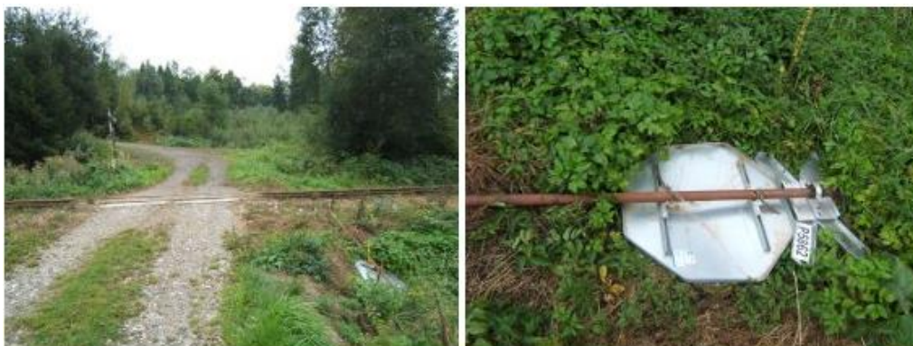
Obr. 4 Ukázka nebezpečného přejezdu s vyvráceným křížem [18]
