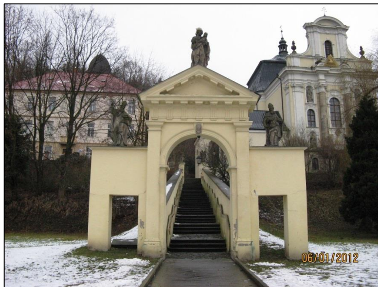
Schodiště před realizací
