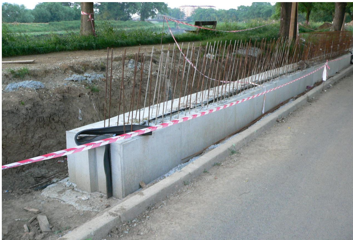
Obr. 27. Stavba protipovodňové ochrany v červnu 2013 [Zdroj: vlastní]
