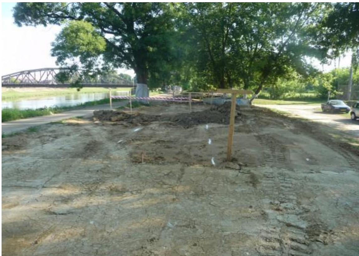
Obr. 31. Úprava Pravobřežní hráze v srpnu 2013 [Zdroj: Pmo.cz]
