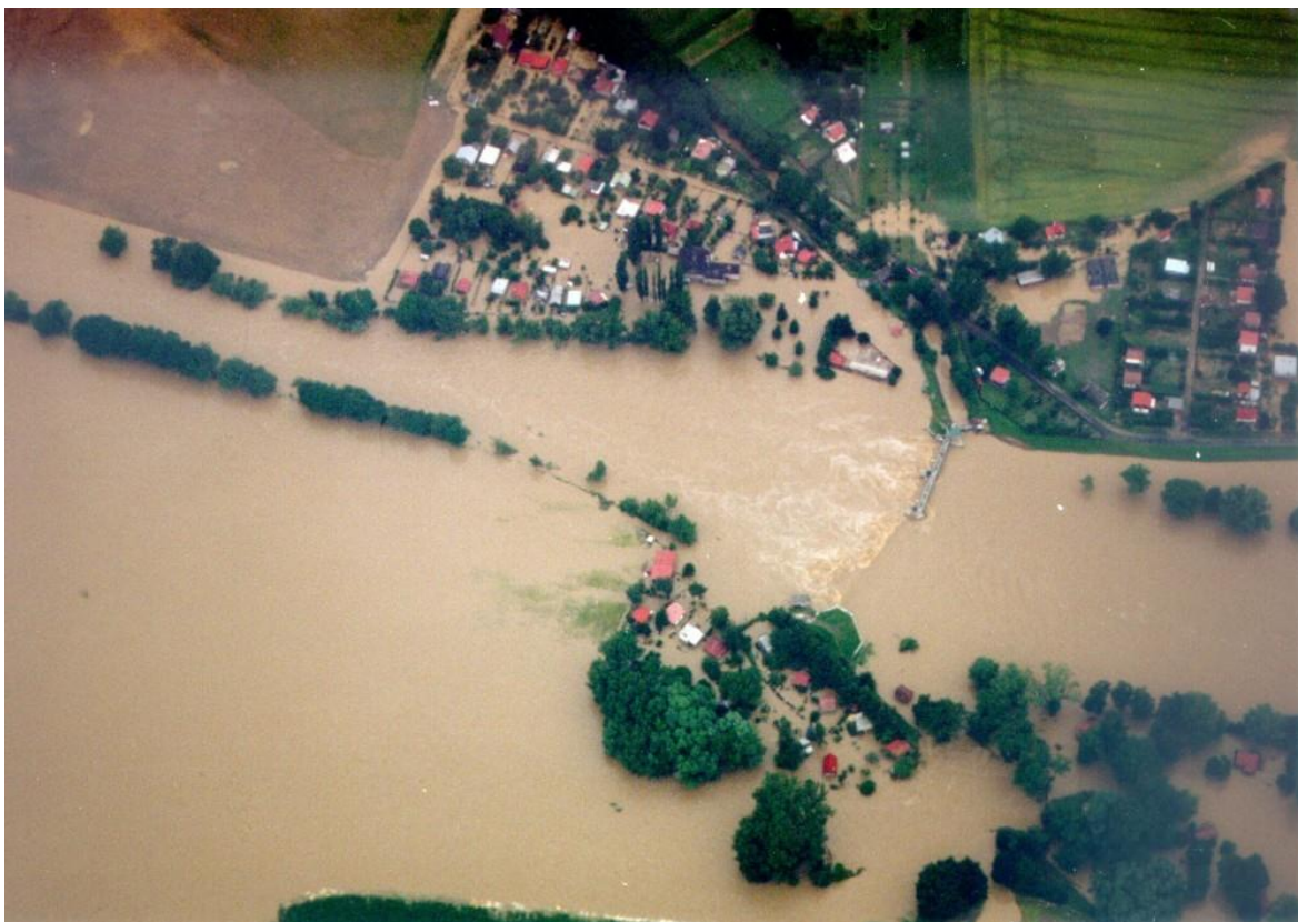
Obr. 23. Jez Osek nad Bečvou dne 9. 7. 1997 [Zdroj: Pmo.cz]
