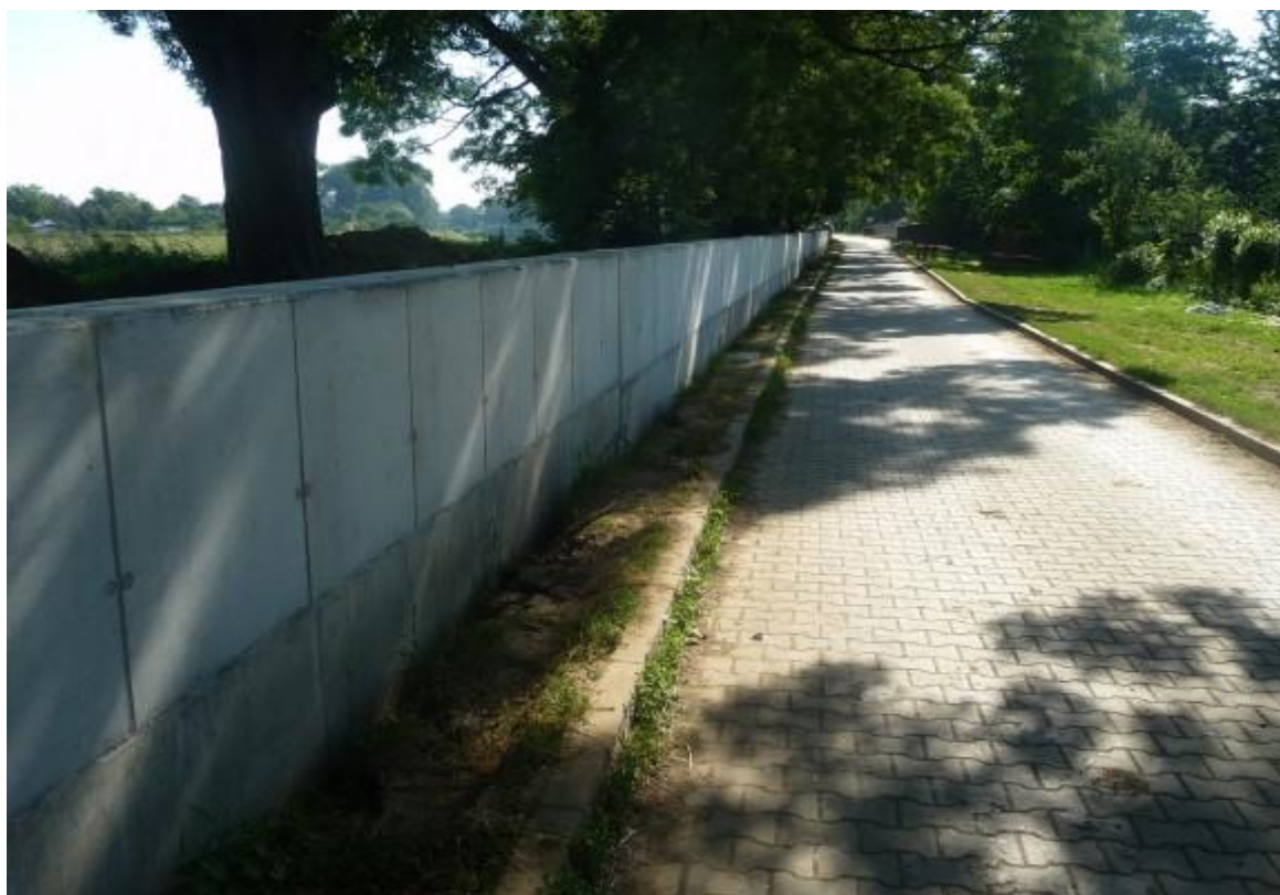
Obr. 30. Dokončující práce zdi v srpnu 2013 [Zdroj: Pmo.cz]
