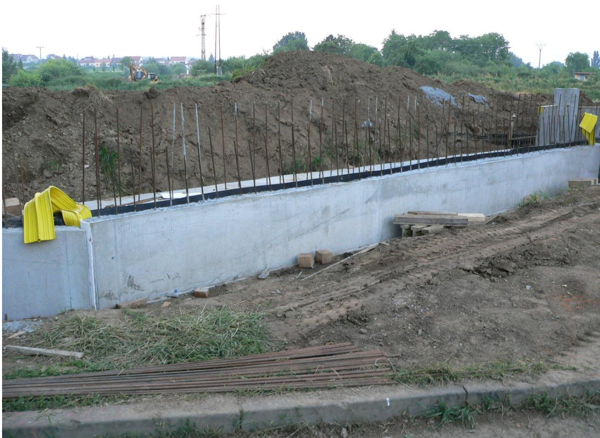
Obr. 29. Stavba základů zdi u čistírny odpadních vod [Zdroj: vlastní]
