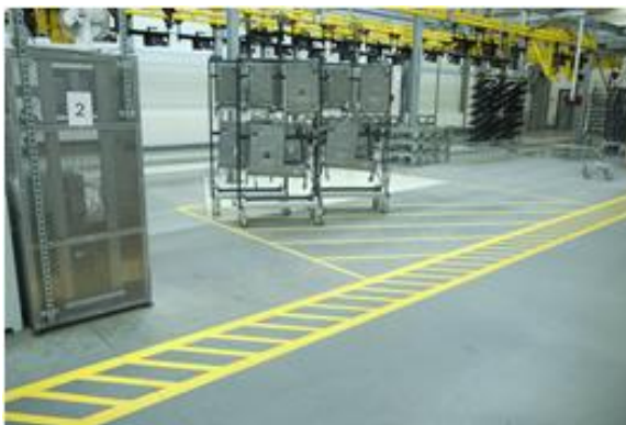
Obr 40. Situace po instalaci podlahového značení – (vlastní zpracování)
