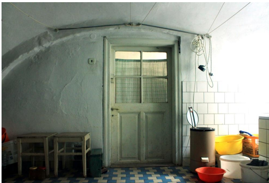
Obr. 32 Místnost původní pekárny, ukázka obloukové klenby, 2015
