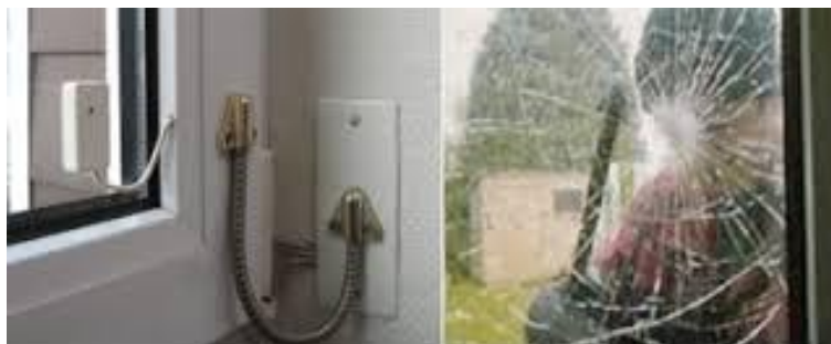
Obrázek 2 Magnetický kontakt a detektor tříštění skla [16]
