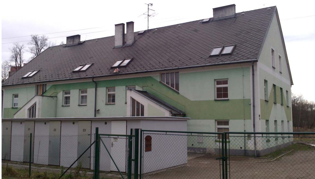
Obr. č. 3: Nové zděné kóje – dřevníky nahradily rozebranou dřevěnou stavbu (foto autor)
