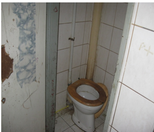
Obr. č. 4: Společná toaleta (foto autor)
