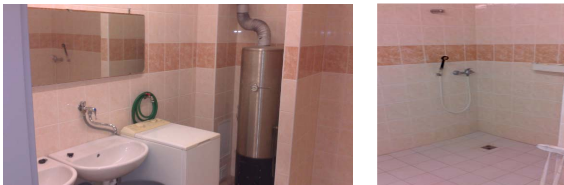
Obr. č. 13 a 14: Společná koupelna se sprchovým koutem, lázeňskými kamny a umyvadly (foto autor)
