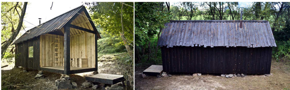
Obr. 20. Obecní sauna v Dúbravici
