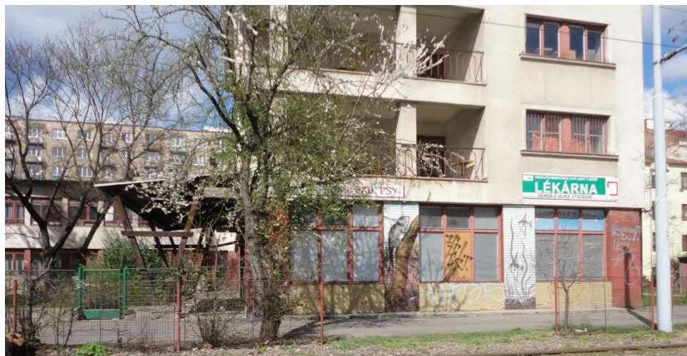
Obr. 3. Objekt pro firemní školku (vlastní foto)
