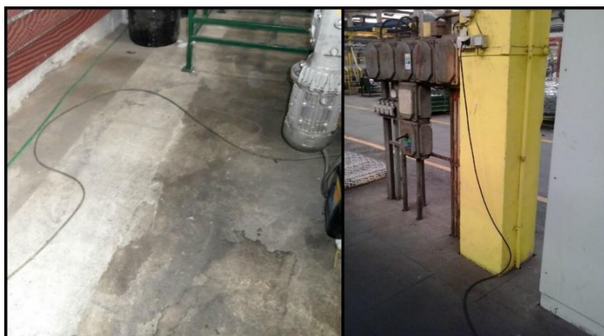
Obrázok 26: Nesprávne upevnená kabeláž (Vlastné spracovanie)
