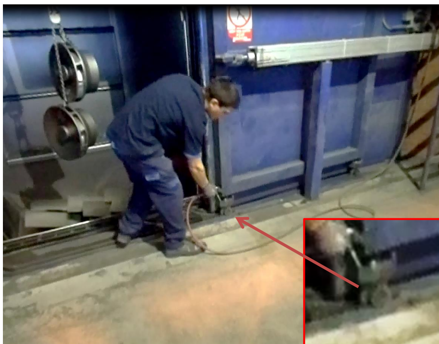
Obr. 39 Ofukování drážky dveří a problémové místo dveří (vlastní zpracování)
