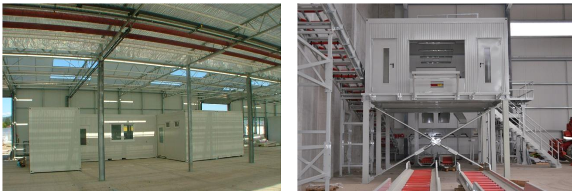
Obr. č. 22: Ukázka z dokončovacích prací
