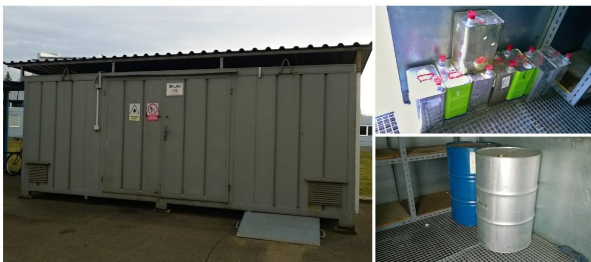
Obr. 8: Sklad hořlavých kapalin, zdroj: [vlastní]
